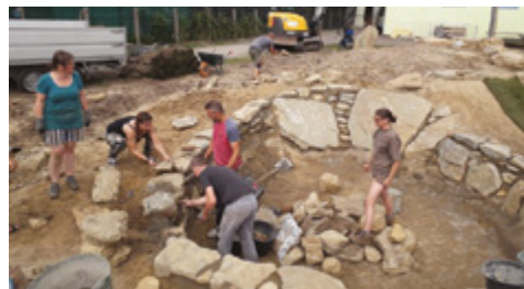
Co-construction d'une cour de récréation avec des parents, Rivierspeelplaats, Kleuterschool de Tovertuin, Lokeren, Groenman 2019
